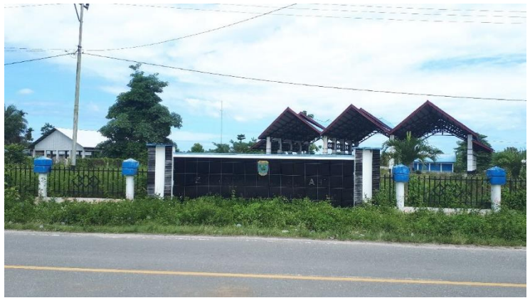
Gambar 3. 8 Terminal Momi Waren Kabupaten Manokwari Selatan
